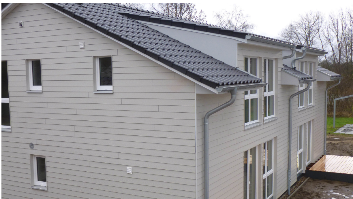
Projekt Flüchtlingswohnungen in Ammersbek vom Gemeinschaftsprojekt pro Flüchtling + Bürger, einer Initiative aus acht Zimmereien, Generalunternehmer ist Holzbau Gehrman GmbH.
