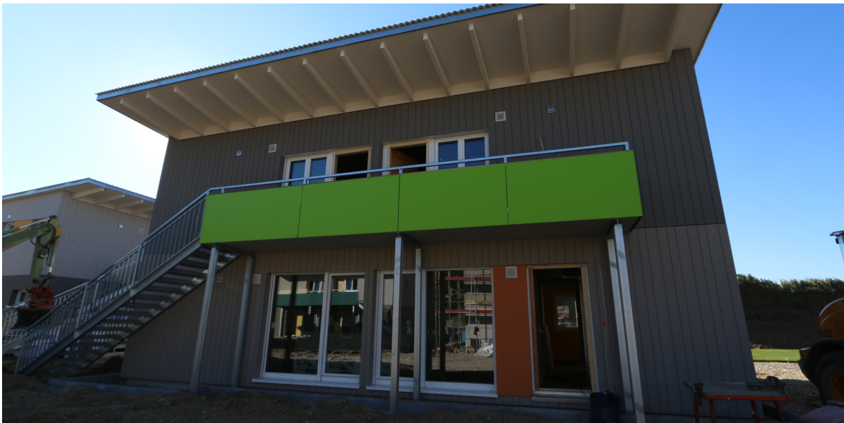
In Königsbrunn bei Augsburg entstanden von August bis November 2015 Unterkünfte für 120 Flüchtlinge in acht kleineren, zweigeschossigen Gebäuden.
